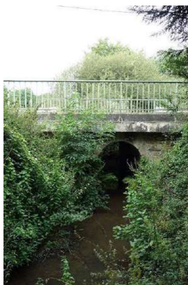
Aménagement permettant l'écoulement de l'eau et le passage des animaux.
