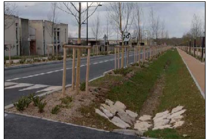
Photos 4 et 5 : Exemples de noues avec cloisons à gauche et paysagère à droite
